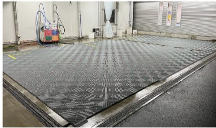
3台分(408枚)のタイルを敷き詰めた作業スペース
