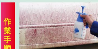
作業手順 茶色い水垢部分に消雪パイプ錆クリーナーをスプレーし、5～10分放置。
