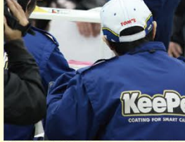
採点者、応援の方々、テレビ局のカメラ...いろいろな視線を感じながらも施工する選手の集中力は半端ではない
